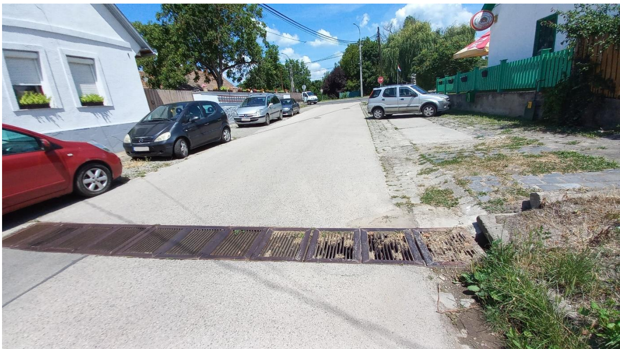
45. ábra. A kerékpározás szempontjából balesetveszélyesen elhelyezett vízvezető rács az Árpád utcában
